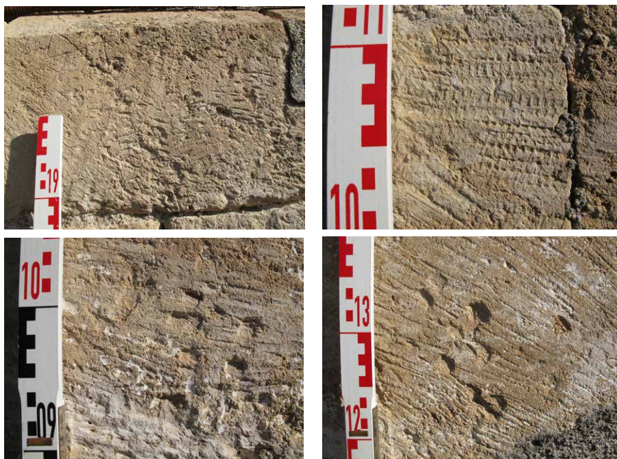
Figuras 2-5. Distintos picados conservados en la piedra dejados por el uso de diferentes herramientas
