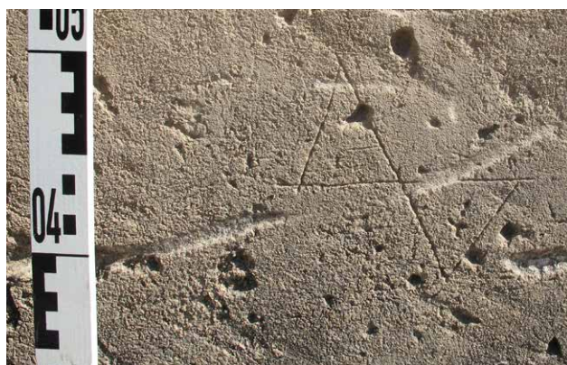
Figuras 7 y 8. Diferente técnica de ejecución de marcas: con cincel e incisa
