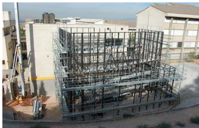
Fig. 6. Trabajos de construcción del edificio anexo, exterior.
