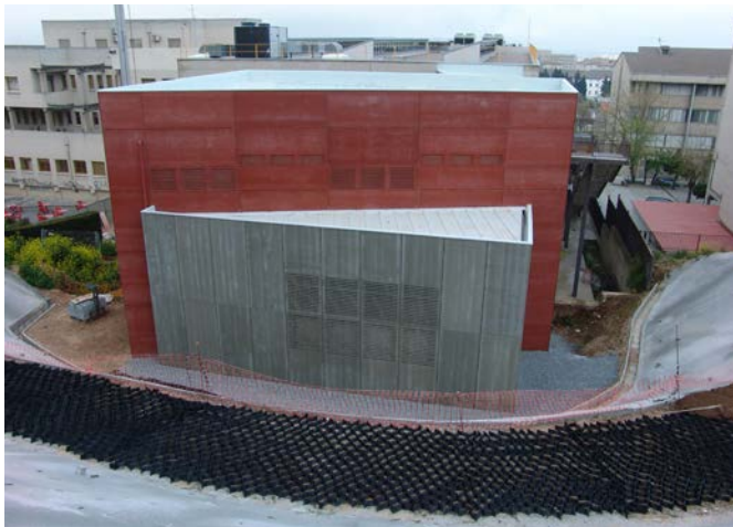
Fig. 8. Trabajos de construcción del edificio anexo, exterior.
