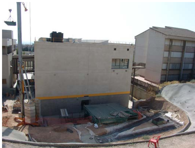
Fig. 5. Trabajos de construcción del edificio anexo, exterior.
