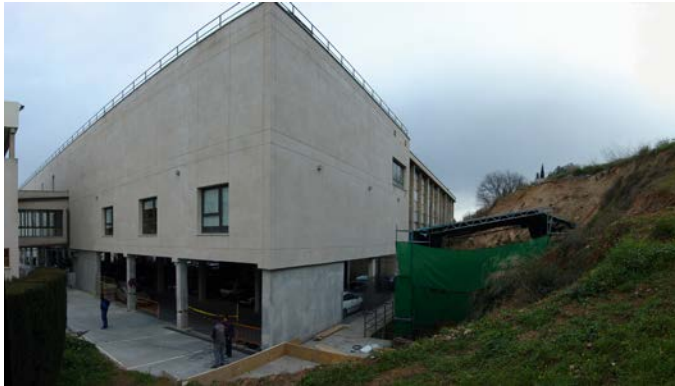
Fig. 4. Trabajos de construcción del edificio anexo, exterior.
