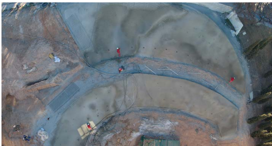
Fig. 10. Vista de los trabajos de construcción de la berma y muro de contención localizado.
