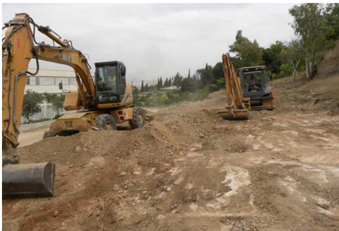
Fig. 4. Movimiento mecánico de tierras de desbroce de la Zona 2-3.
