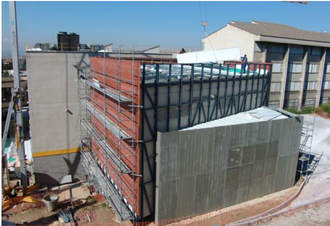
Fig. 7. Trabajos de construcción del edificio anexo, exterior.
