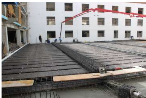
Encofrado y armaduras para el forjado del patio nuevo – techo aula magna. Año 2012
