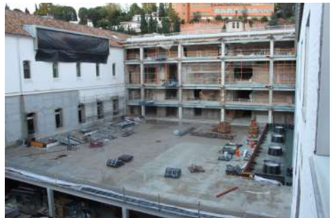
Inicio de los trabajos de eliminación de la estructura metálica auxiliar, que se levantó en el interior del aula magna. Año 2012
