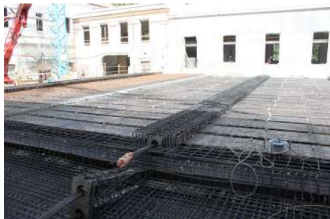
Armadura completa del forjado del patio nuevo – techo aula magna y preparación para el pretensado de las grandes vigas. Año 2012
