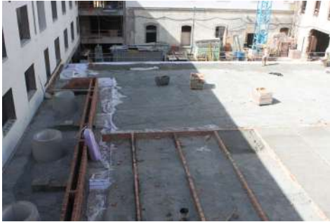
Preparación del acabado de suelo del patio nuevo – techo aula magna. Año 2012
