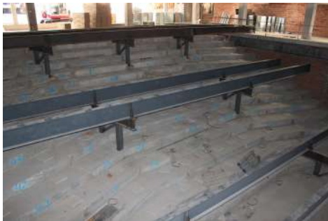
Interior del aula magna con la estructura auxiliar metálica, que se montó para el encofrado de la cubierta – forjado patio nuevo. Año 2012
