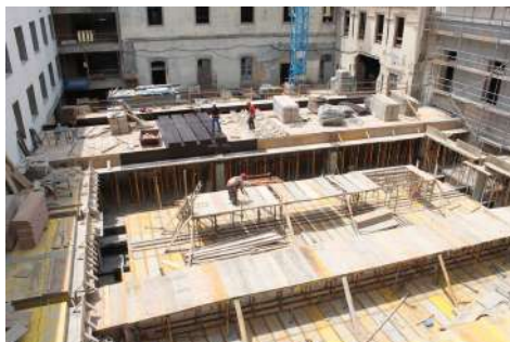
Preparación del encofrado de las vigas del forjado del patio nuevo de la Escuela de Arquitectura, bajo el cual quedará situada el aula magna. Año 2012
