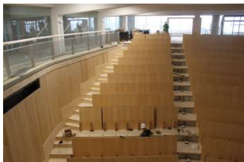
Interior del aula magna, trabajos de carpintería: colocación de asientos y forrado de escaleras. Año 2014
