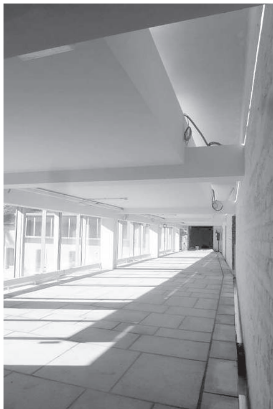
Encuentro de vigas de hormigón y muro de fábrica en la galería.
