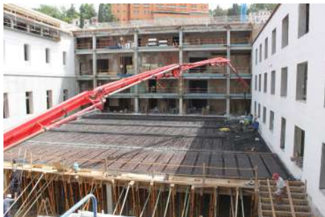
Vista del patio nuevo y encofrado de la cubierta del aula magna. Año 2012
