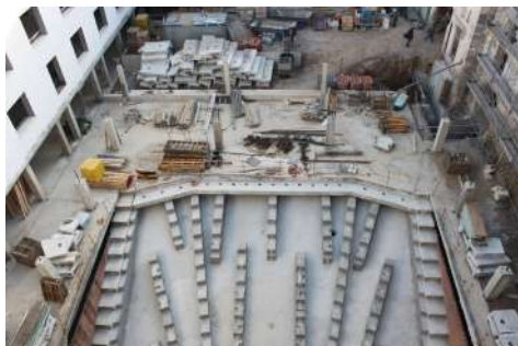
Desmonte de las gradas del aula magna y replanteo de pilares metálicos. Año 2012
