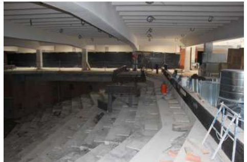
Inicio de los trabajos de eliminación de la estructura metálica auxiliar, que se levantó en el interior del aula magna. Año 2012
