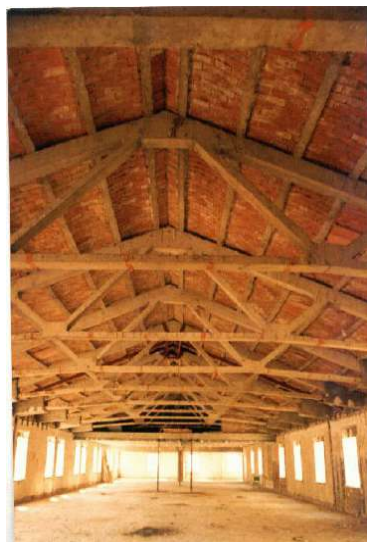
Fig. 20 - Estado antes de la intervención. Cubierta de vigas trianguladas
