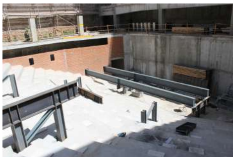
Montaje de las gradas del anfiteatro. Año 2012
