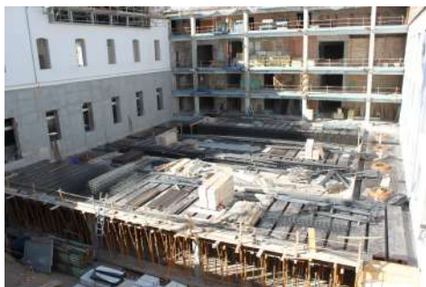
Armadura de las grandes vigas del forjado del patio nuevo – techo aula magna, dispuestas sobre el encofrado. Año 2012
