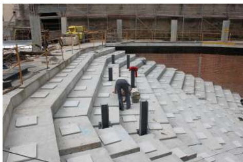
Protección de las perforaciones cilíndricas de las gradas y montaje de los pilares metálicos de la estructura auxiliar. Año 2012.
