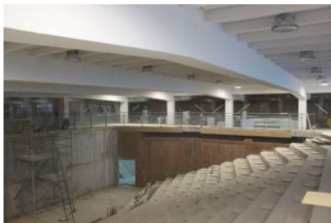
Interior del aula magna. Obsérvese las grandes vigas de hormigón con armadura pretensada in situ. Año 2014
