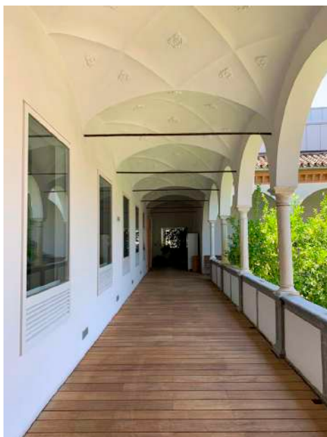
Fig. 10 - Galería construida mediante bóvedas vaídas
