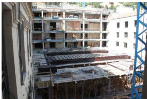
Encofrado del forjado del patio nuevo de la Escuela – techo aula magna. Año 2012
