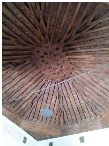
Fig. 8 - Armadura de lazo situada en el techo de la Sala de dirección
