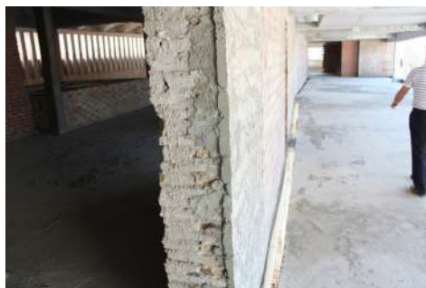
Detalle de la fisura de separación entre el muro de la casa de Stefano Centurione y el forjado de la galería. Año 2011
