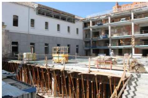
Hormigonado del forjado del patio nuevo – techo aula magna. Regado del hormigón. Año 2012
