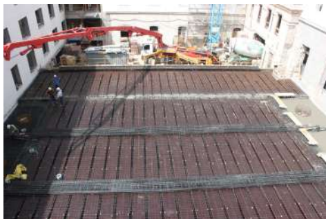
Vista del patio nuevo y encofrado de la cubierta del aula magna. Año 2012
