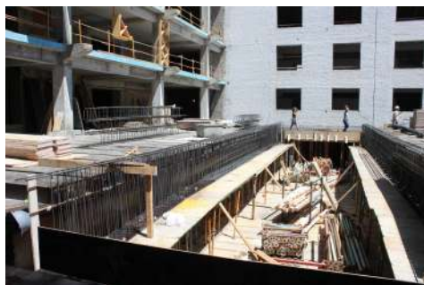
Encofrado del forjado del patio nuevo de la Escuela – techo aula magna. Obsérvese el encofrado entre vigas. Año 2012
