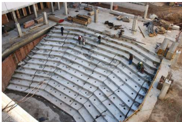
Perforaciones en las gradas del anfiteatro aula magna, durante las obras de restauración. Año 2012
