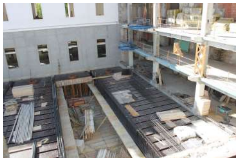
Encofrado del forjado del patio nuevo de la Escuela – techo aula magna. Obsérvese el encofrado entre vigas. Año 2012
