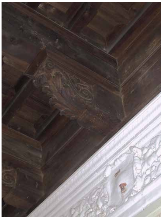
Fig. 9. Vista de uno de los alfarjes de las crujías habitacionales [Fot. L. Ceres, 2001]
