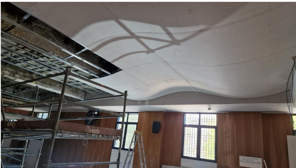
Imagen 2: Instalación del soporte ondulado para la ubicación del lienzo.
