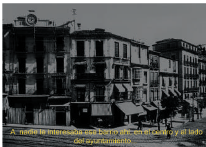
Fig. 2. Esquina de la calle Reyes Católicos con Acera del Casino, antes de la demolición de la Manigua. Fecha y autor/a desconocidos. Archivo periódico Ideal .
