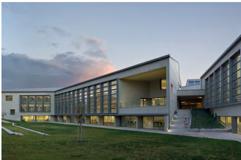
Edificio de servicios centrales del Campus de Ciencias de la Salud | foto Cruz Ortiz Arquitectos
