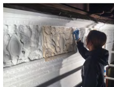
Restauración del friso del Salón de Rectores, Hospital Real. Intervención in situ . Detalle | fotos Teresa López
