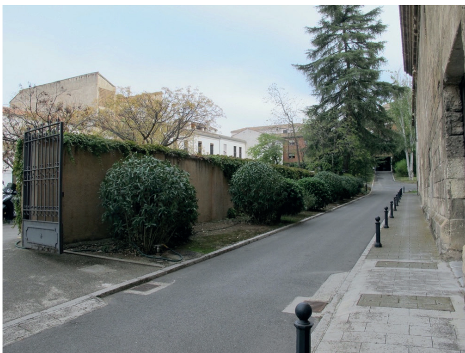
Fot. 2 y 3. Vista de la tapia. Fotografías del autor, 2025
